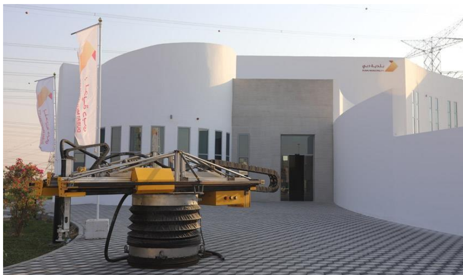
Figura 4 – Outra vista do Edifício em Dubai
